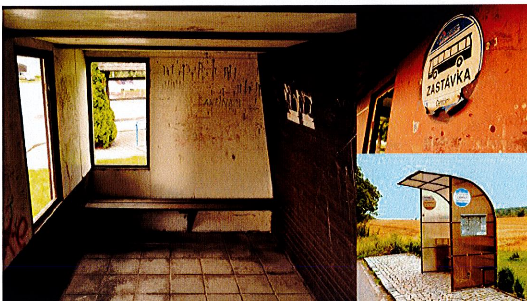
Autobusové zastávky jsou ve špatném stavu.
